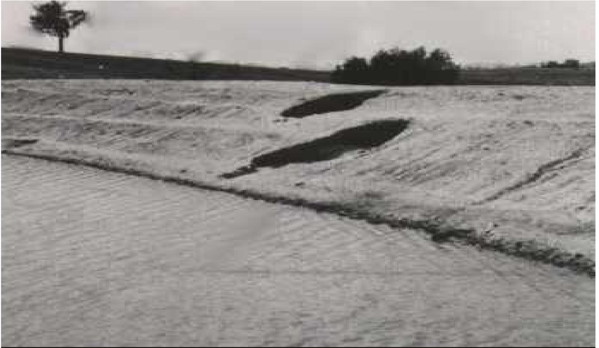
**Ejemplo de falla por tubificación en una presa debido a la presencia de suelos dispersivos**
