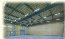
大規模流通に対応した保管施設
