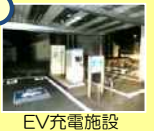
EV充電施設
