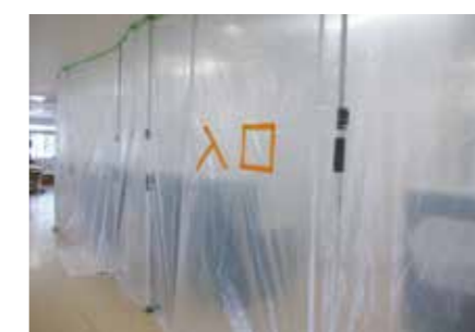
ICU/ステーション間仕切り
