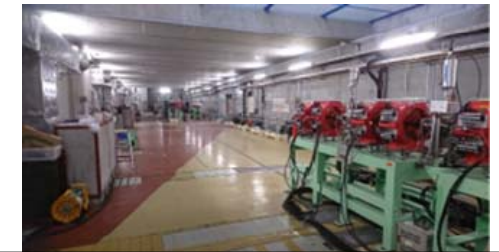
改造部の機器撤去 (2019年12月初)
