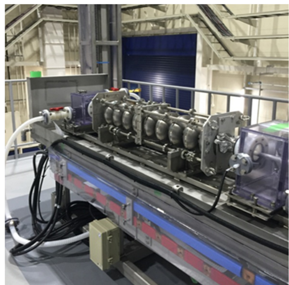
Figure 4: 空洞に治具と配管の取り付け.
