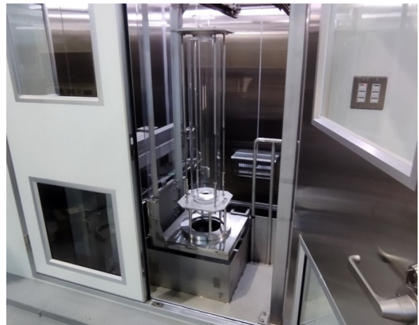
Figure 3: 空洞の超純水高圧洗浄(HPR)を行う HPR 設備.
