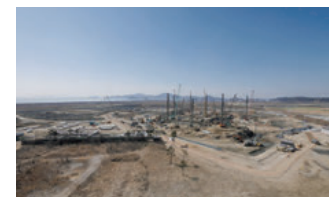
建設工事の様子
