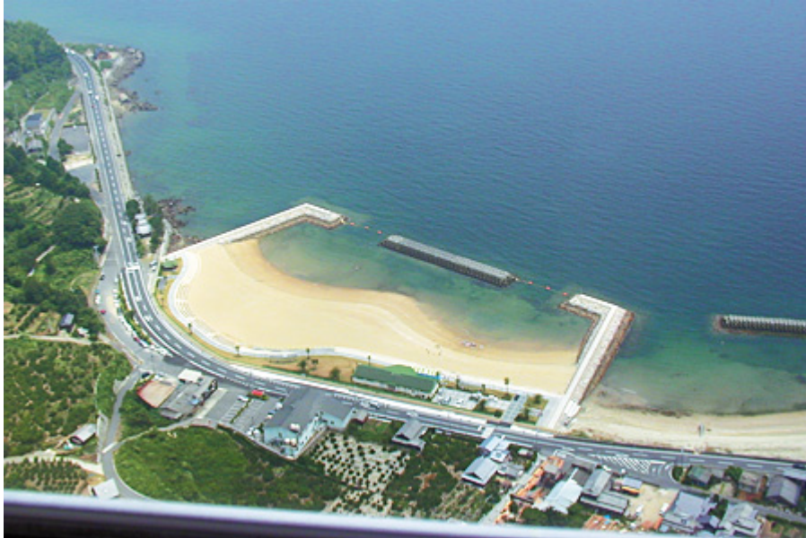
人工海浜として整備された海岸(久賀港海岸)
